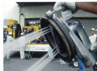
コンクリート片はく落防止対策工事 (壁高欄施工)
