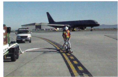
空港内における区画線消去工事
