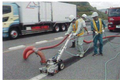
高速道路における四車線化工事
