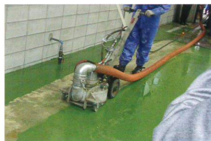
床エポキシ除去
