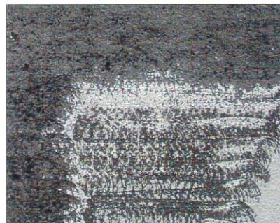
外装塗装の除去
