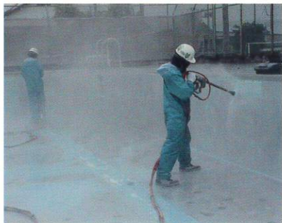
ブール塗膜除去
