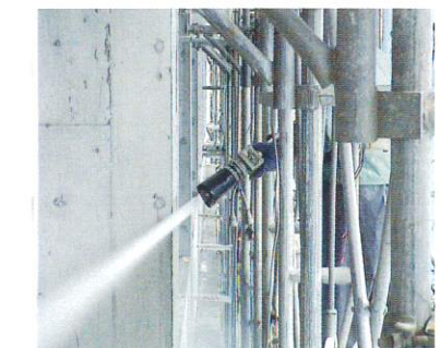
タイル貼り下地処理
