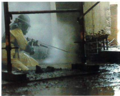
コンクリート柱はつり
