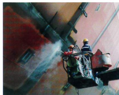
溶接線のはく離作業
