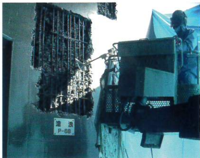
橋脚劣化除去
