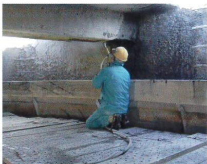
下水処理場劣化除去
