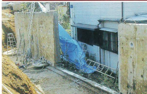
住宅地での擁壁撤去
